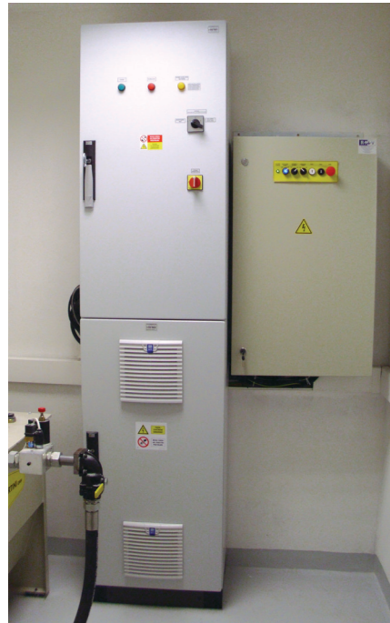
▲ Napájení výťahu.
