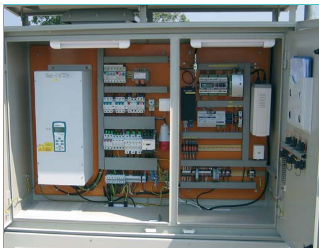
Regulácia závlahového systému s rádiovým ovládaním - nasadený FM VQFREM 400 022.
